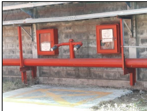
รูปที่ 39 (ต่อ) ระบบดับเพลิงแบบ Fire Hose ภายในพื้นที่โครงการ
