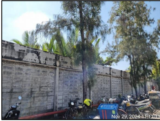
รูปที่ 2 กำแพงถาวรสูง 3 เมตร ที่มีวัสดุดูดซับเสียง ด้านติดกับโรงเรียนศิริวิทยา
