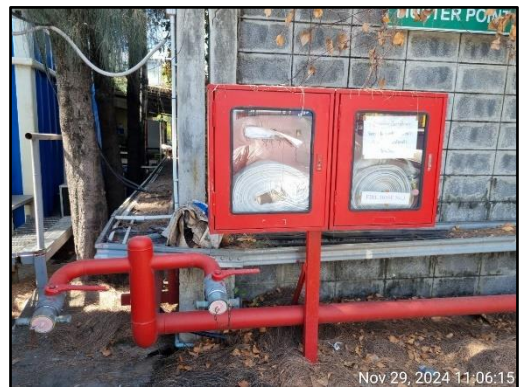
รูปที่ 39 ระบบดับเพลิงแบบ Fire Hose ภายในพื้นที่โครงการ
