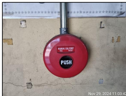
รูปที่ 32 อุปกรณ์แจ้งเหตุด้วยมือ
